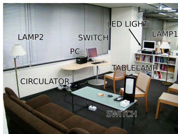
図 6 実験に用いた部屋および機器。被験者は照明などの機器をスイッチモジュールのスイッチに割り当てて操作を求められる。GUI を使う場合は、被験者は PC を操作して設定を変更する。
